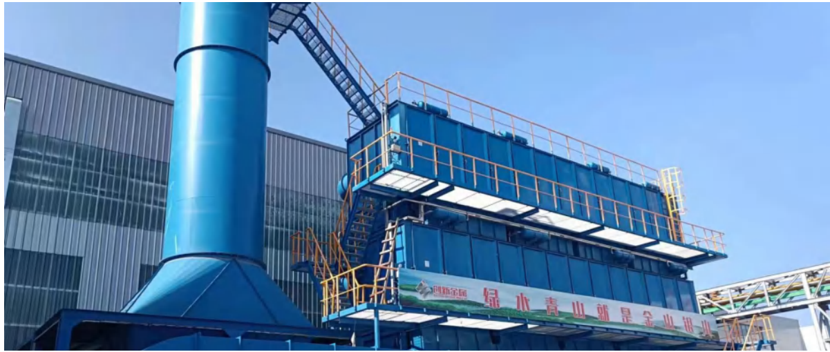
□ 低压脉冲高效除尘器
